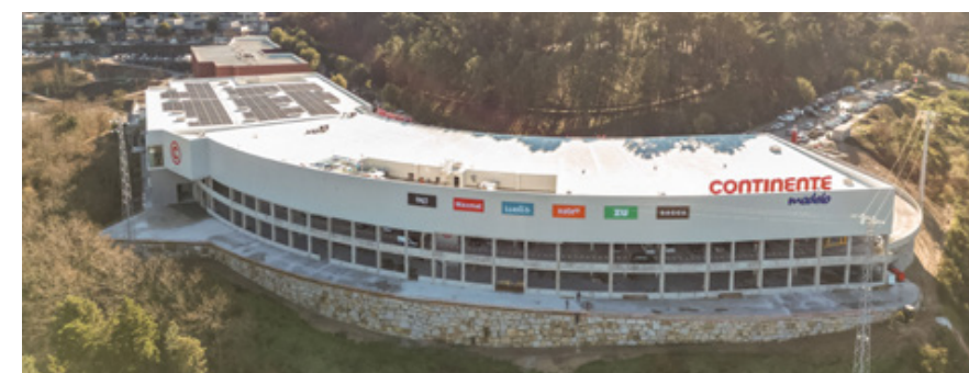
Veduta dall'alto del parcheggio coperto e sopraelevato di un 'Continente Modelo'.
